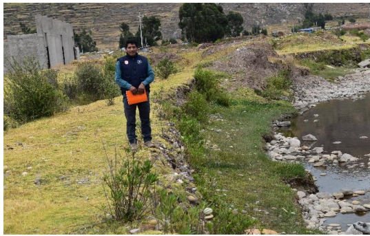
FOTO 01: Se aprecia la ribera margen izquierda del río Salca, talud de Dique Fusible, afectado al pie del tiud por erosión.
