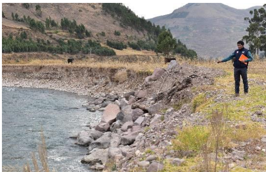
FOTO 03: Se aprecia el curso del agua por la margen derecha aguas abajo del río Salca, que viene afectando por erosión y colapso del talud de la ribera. Afectando áreas de cultivo e propensos a inundación, Localidad del Distrito de Combapata - Canchis - Cusco.
