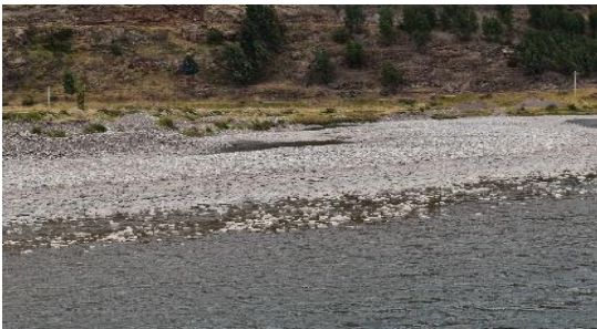
FOTO 05: Cauce colmatado. Se aprecia Aguas abajo margen izquierda taludes naturales en ambas márgenes sin defensas ribereñas. Localidad del Anexo Huatoccani, comunidad campesina de Urinsaya Combapata, Distrito de Combapata - Canchis - Cusco.
